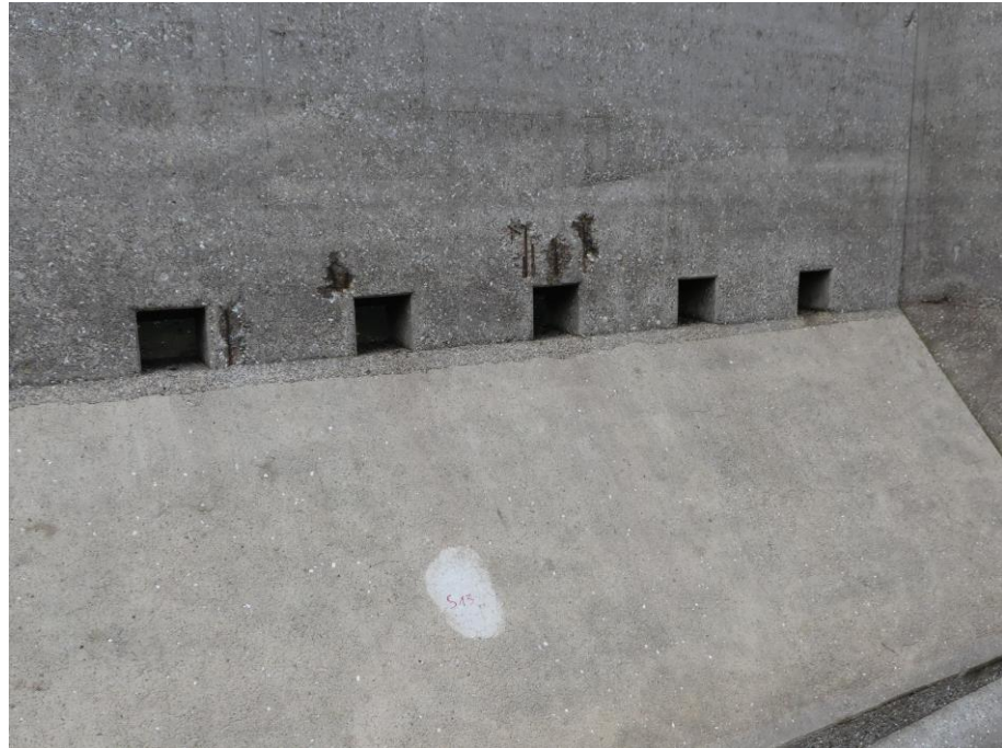
Bild 21 Betonschaden Einlaufseite – beispielhaft
