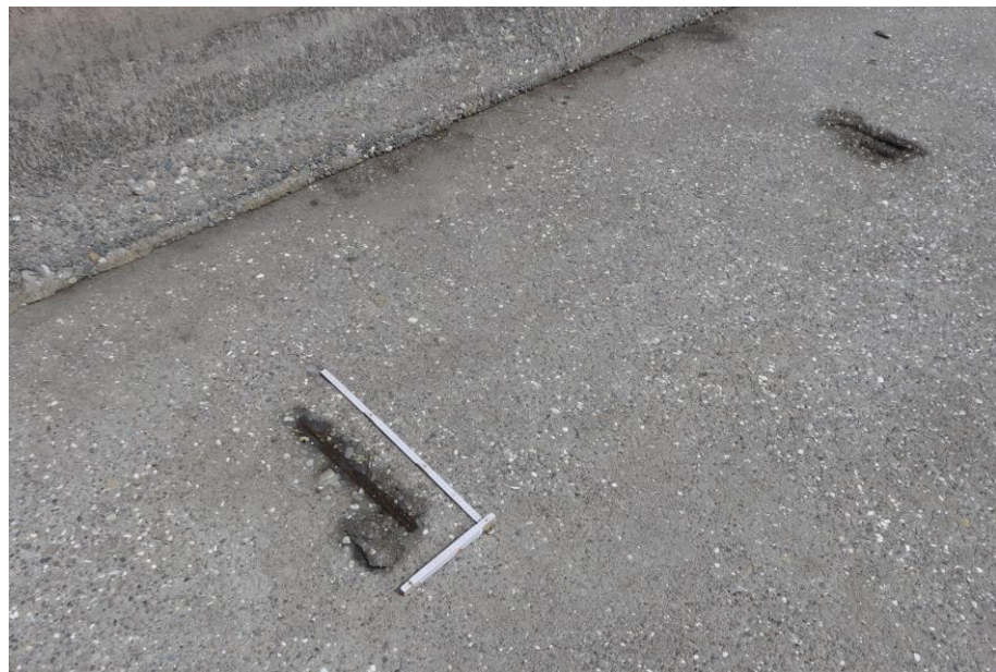
Bild 24 Betonschaden + korrodierte Bewehrung – Bodenplatte – beispielhaft -2
