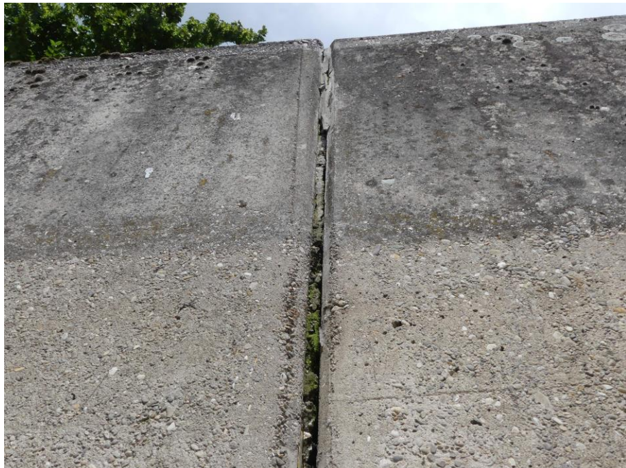
Bild 20 beispielhaft Bauwerksfuge am Wandkopf
