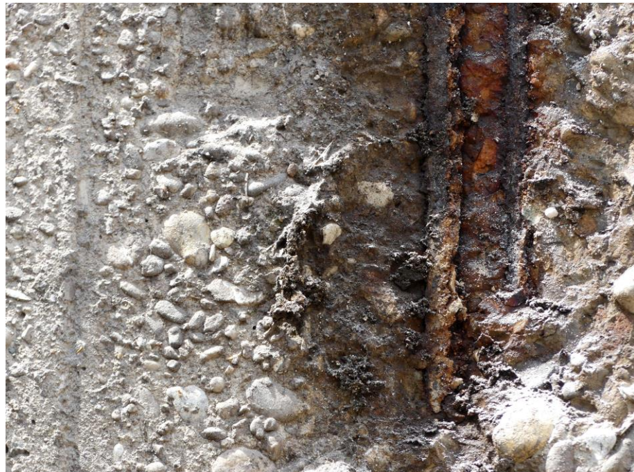
Bild 22 Detail Betonschaden Einlaufseite
