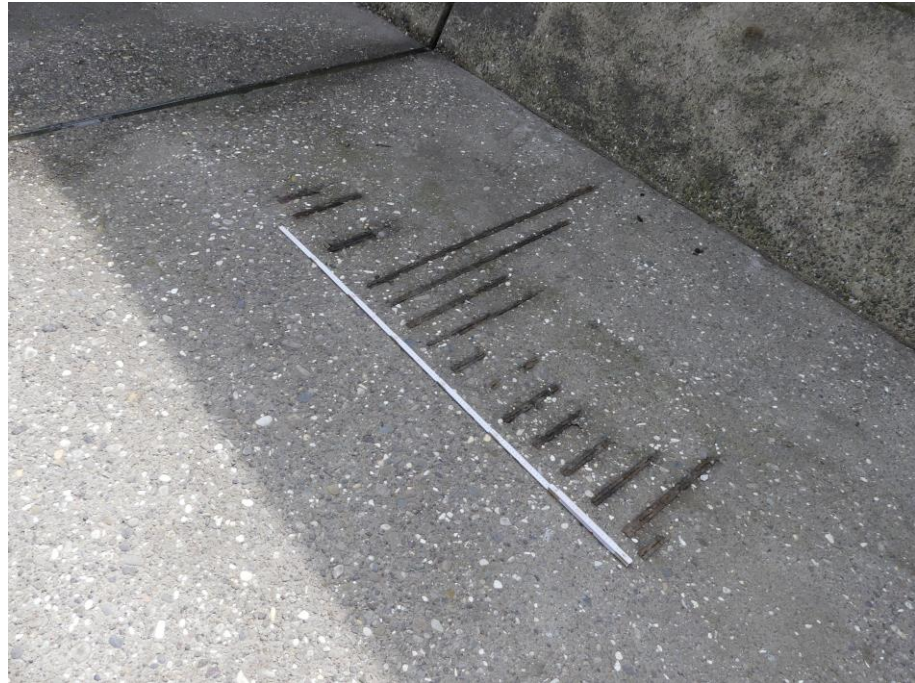
Bild 23 Betonschaden + korrodierte Bewehrung – Bodenplatte – beispielhaft -1
