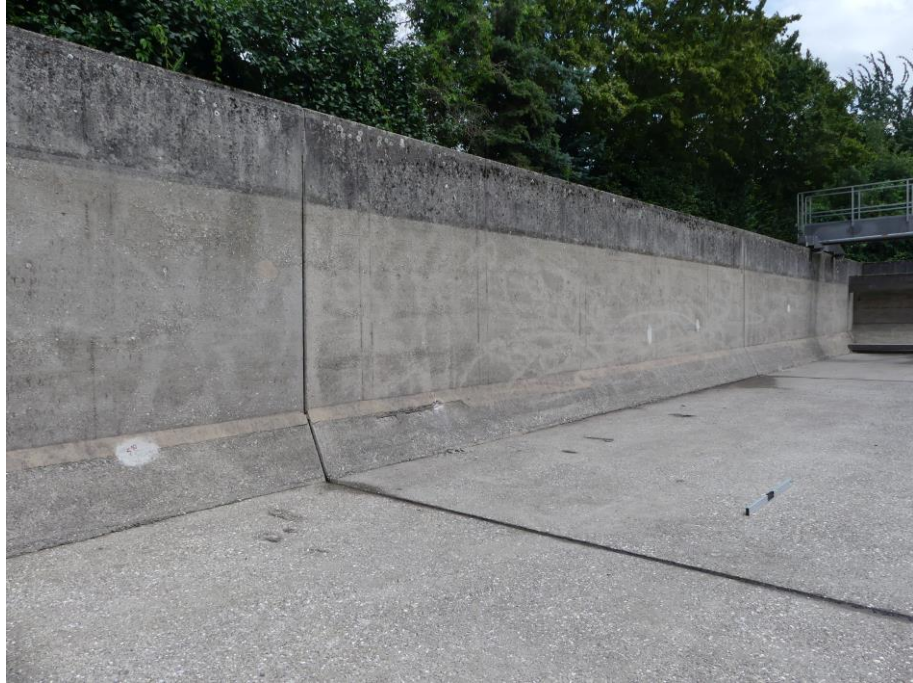
Bild 17 beispielhaft Bauwerksfuge
