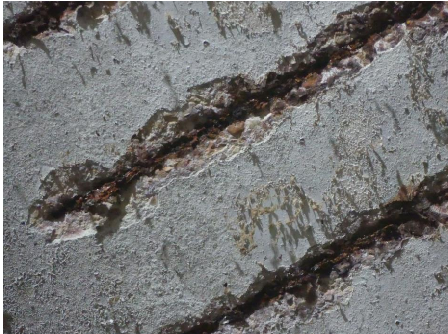
Bild 10 Detail Bewehrungskorrosion
