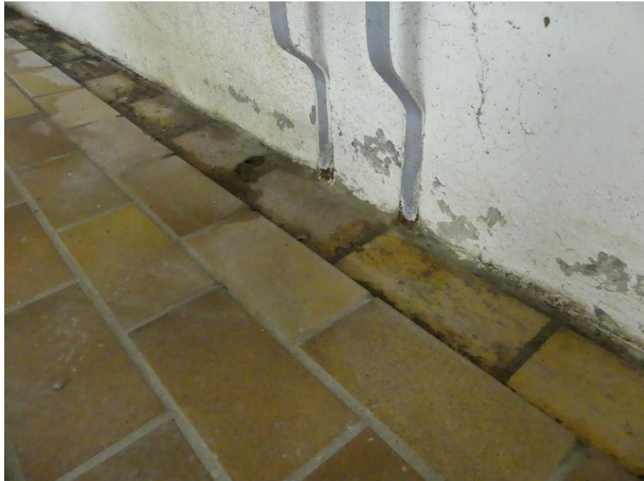
Bild 4 Feuchtebelastung Boden-Wand-Fuge im UG
